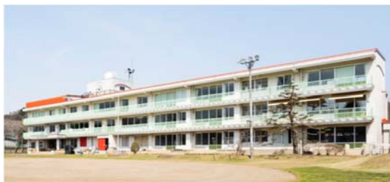
「ICT KŌBŌ」が入居する旧三水第二小学校校舎 を活用した施設「いいづなコネクト EAST」
